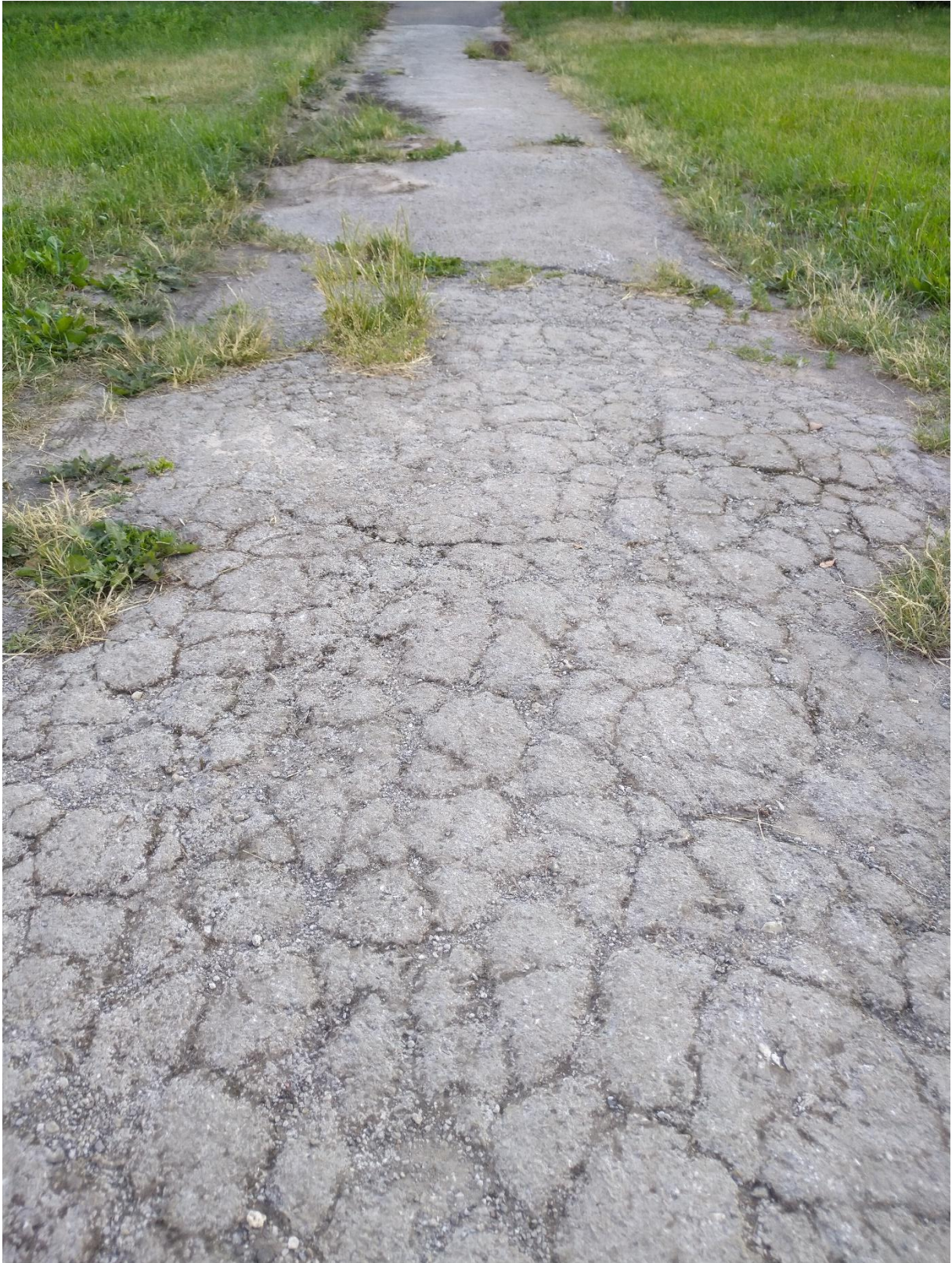
Joonis 1. Akadeemia tee 42 ja Akadeemia tee 32b vahelise kõnnitee seisukord (lõhenenud ebatasane asfalt, umbrohu mügarikud)
