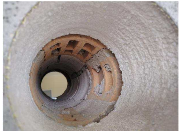
Ventilatsiooniava läbilõige (kips, silikaattellis, kõrgtellis, soojustus, krohv)
